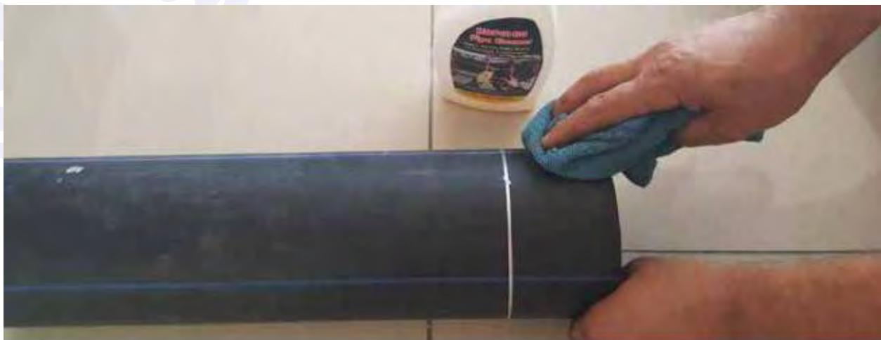
**Temizleme:** Boru uçları temiz ve toz, topraktan arındırılmış olmalıdır. Boru uçlarından çapak ve ya kazıma artığı malzemeyi alkollü bez ve ya alkollü solüsyon kullanarak temizleyiniz. Bu işleminden sonra boru uçlarının tekrar kirlenmemesine dikkat ediniz. Manson iç kısımının da temiz olmasına dikkat edilmelidir.
